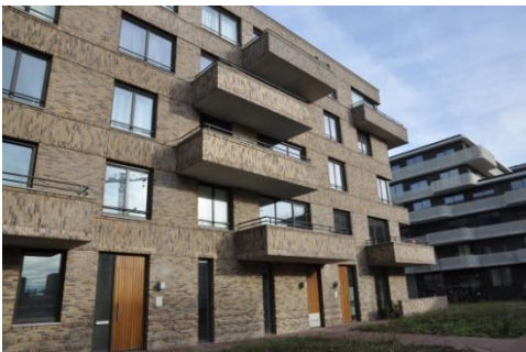
Probleemloos uitkragende balkons in combinatie met kanaalplaatvloeren
