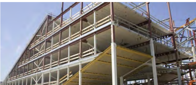
Staalstructuur in combinatie met kanaalplaatvloer
