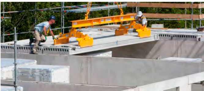
Dragende wanden van beton
