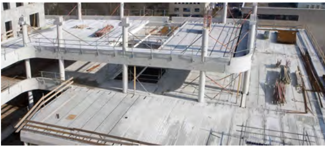
Betonstructuur 'gevel-gevel' met kanaalplaatvloer
