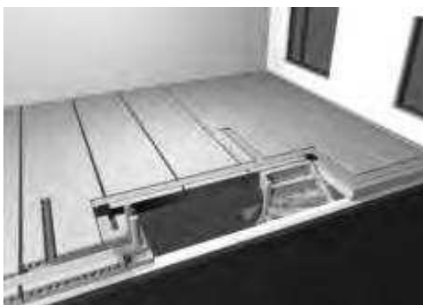
Oud situatie: raveelijzer in het zicht
