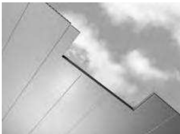
Nieuwe situatie: raveelijzer uit het zicht
