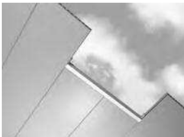
Oud situatie: raveelijzer in het zicht
