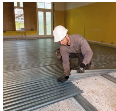
PS-renovatievloer Semi-droog afwerking met zwaluwstaartplaten en beton of gietmortel.
