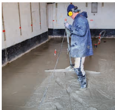
PS-renovatievloer Standaard afwerking met betonnen druklaag.
