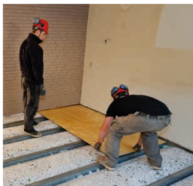
PS-renovatievloer Droog afwerking met plaatmateriaal.
